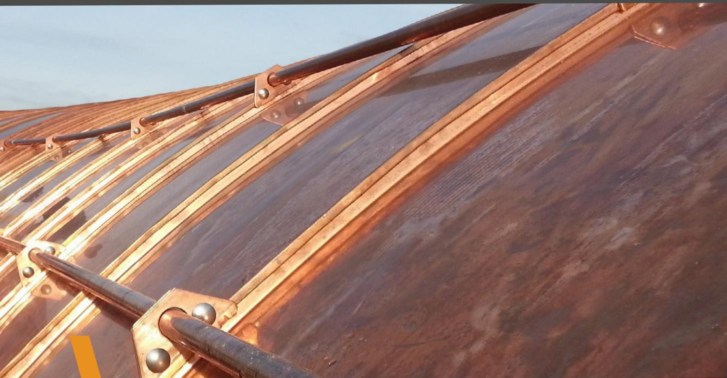
Il **sistema aggraffato** è una scelta **affidabile** e **duratura** per i tetti, grazie alla sua resistenza alla corrosione, facilità di installazione e versatilità.
