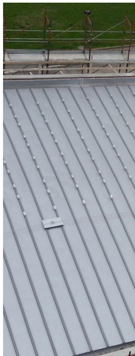
Realizzazione di sistema di copertura antisismica ed ecocompatibile con pannelli speciali in alluminio a bassa pendenza, rastremate e con giunto drenante – Realizzazione struttura portante in acciaio su tetto piano
