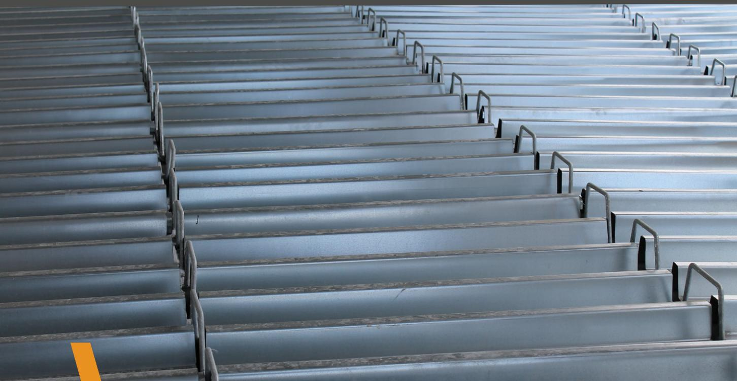
Le **coperture speciali** di MR COPERTURE prevedono l'utilizzo di lastre metalliche lunghe senza perforazioni, profilate in loco con giunti drenanti.
